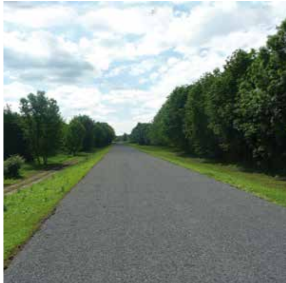
Koruna Skařinské hráze po rekonstrukci
