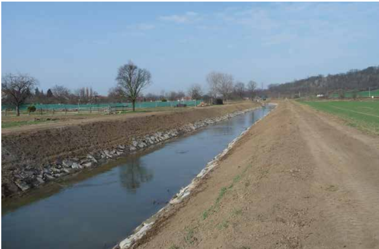
Koryto Litavy v obci Marefy po opravě
