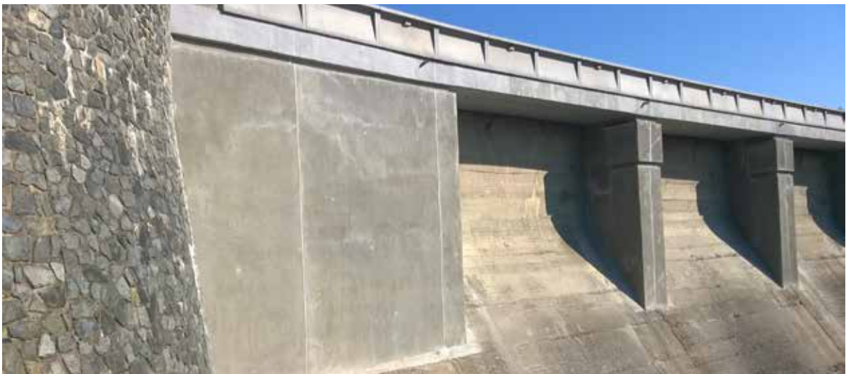
Pilíře na vzdušné straně hráze VD Vír ↓
