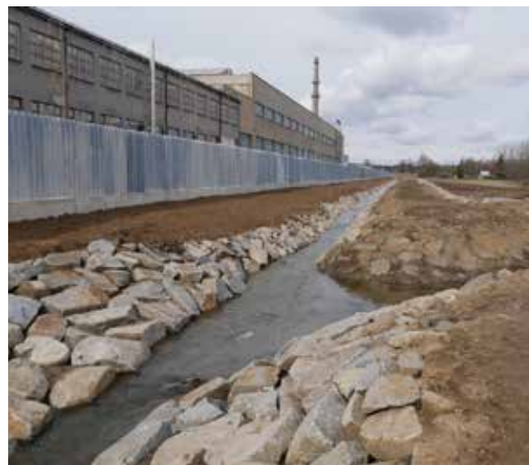
↑ Dokončená výstavba protipovodňové ochrany města Svitavy
