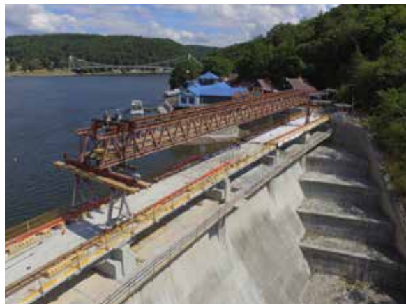
↑ Provádění prací pomocí technologie tzv. horní skruže na VD Vranov
