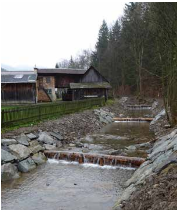
↑ Dřevěné prahy a opevnění břehů toku Velká Stanovnice
