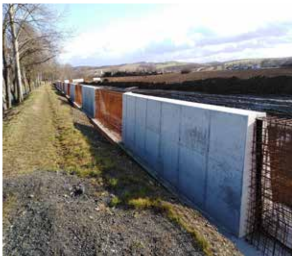
↑ Probíhající výstavba protipovodňových zdí v Kunovicích
