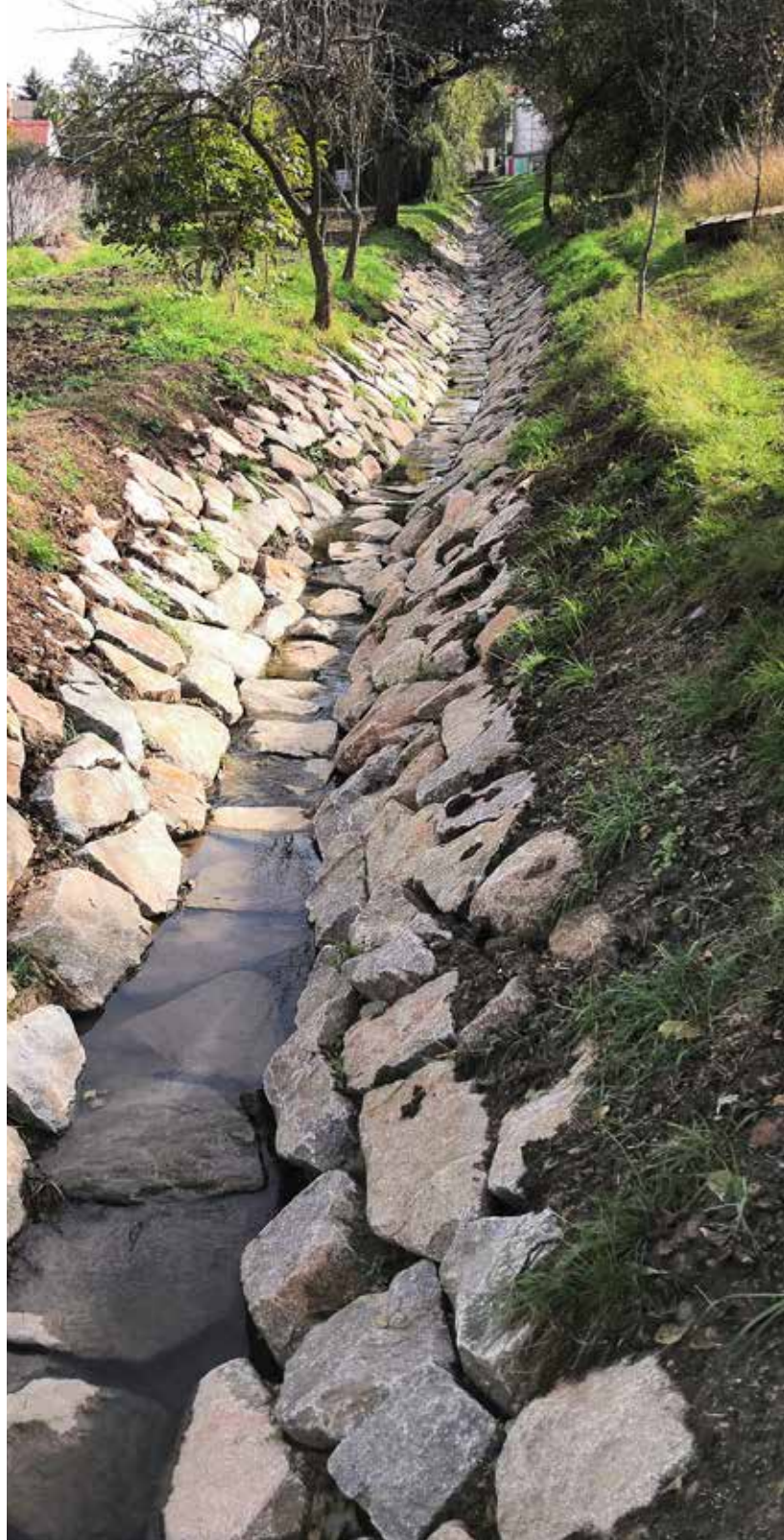
Koryto Prackého potoka →
