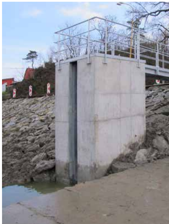
↑ Opravený výpustný objekt VD Bidelec
