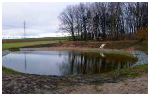
↑ Vycištěná nádrž Tetětice
