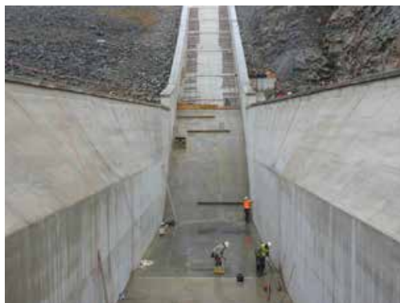
↑ Rekonstrukce vývaru VD Boskovice
