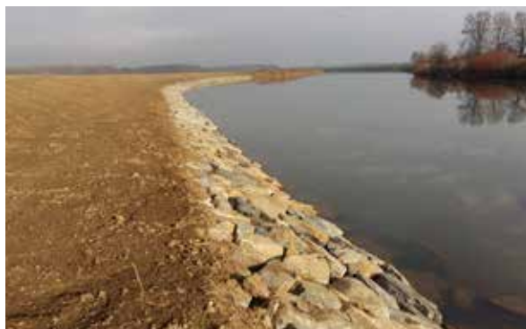
↑ Břeh řeky Moravy těsně po dokončení sanace nátrže
