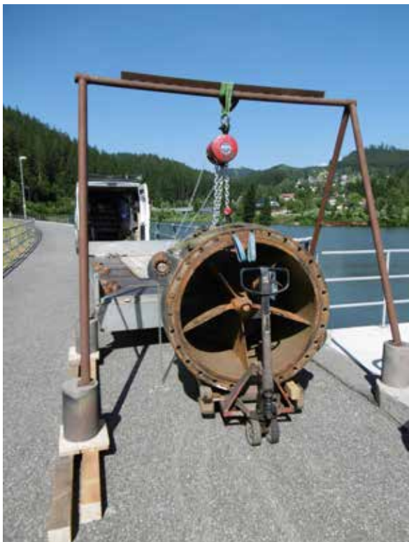
← Rozstříkovací uzávěr spodní výpusti před repasí
