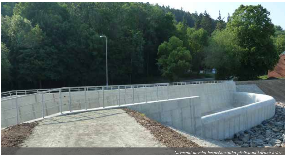
Navázání nového bezpečnostního přelivu na korunu hráze
