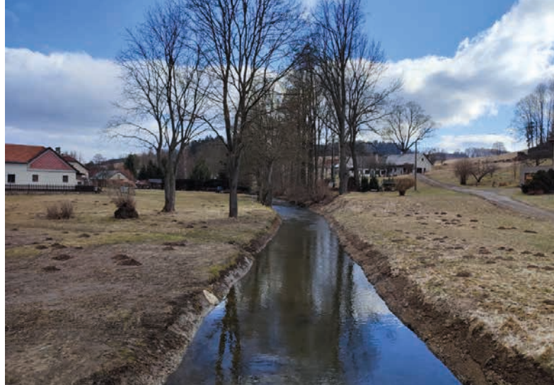
Bílý potok v obci Sádek po odtěžení nánosů ↑
