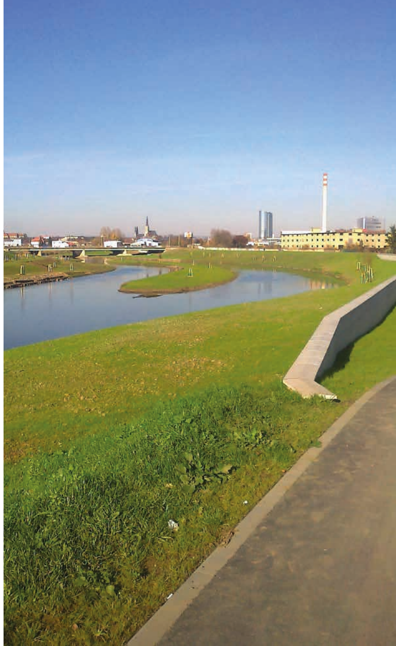
Dokončená II. A etapa protipovodňové ochrany města Olomouc, ↑ pohled na paralelní koryto a 350 m dlouhý zelený ostrov, 2013
