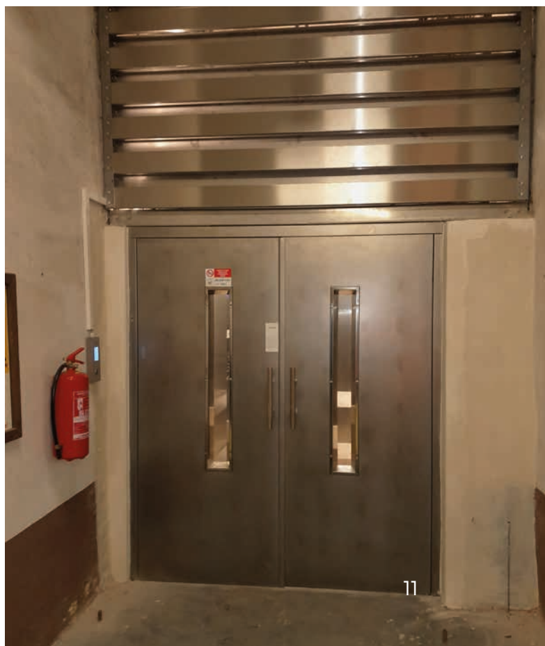
Dveře výtahu ve strojovně s žaluziemi pro přívod vzduchu →
