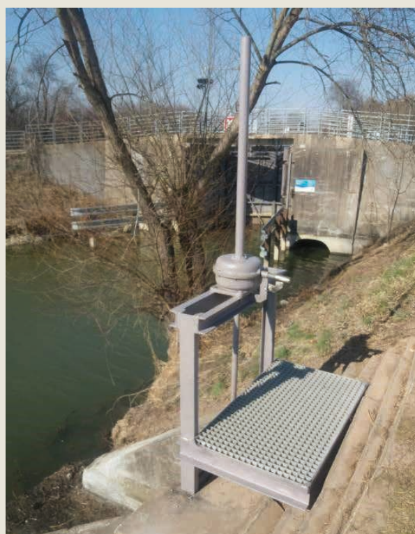
Opravený tabulový uzávěr v Petrově →
