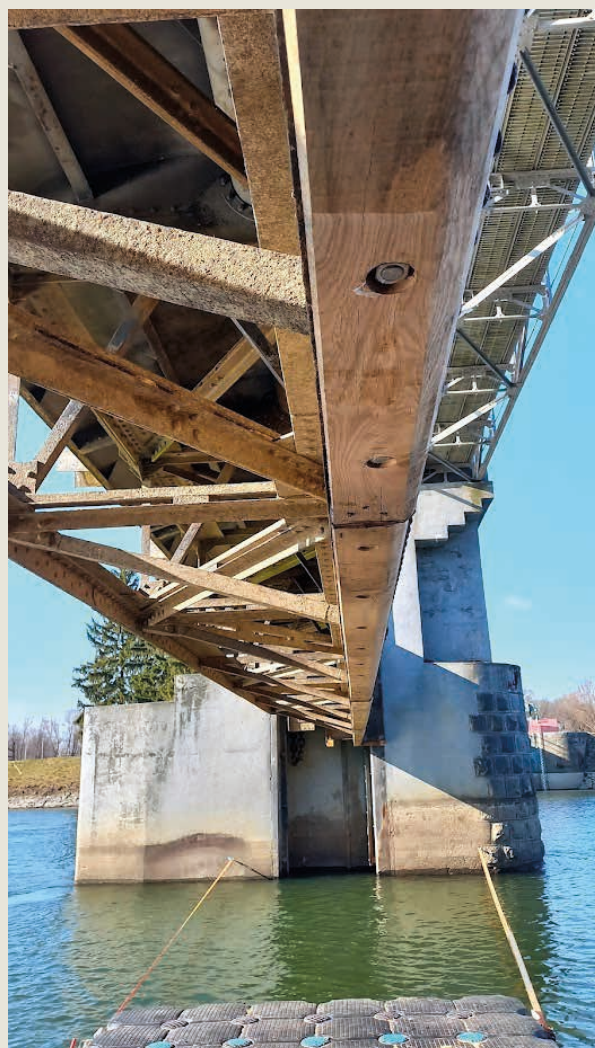
Vyměněné prahové těsnění ↑
