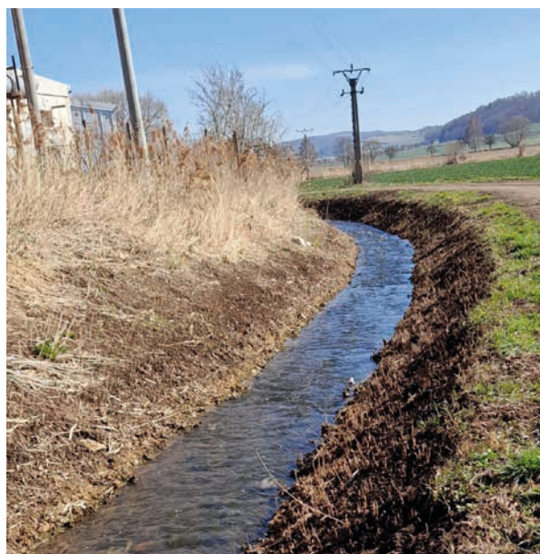
Plně obnovený průtočný profil Malonínského potoka
