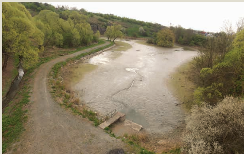
Vodní nádrž Santon před letošní opravou ↑
