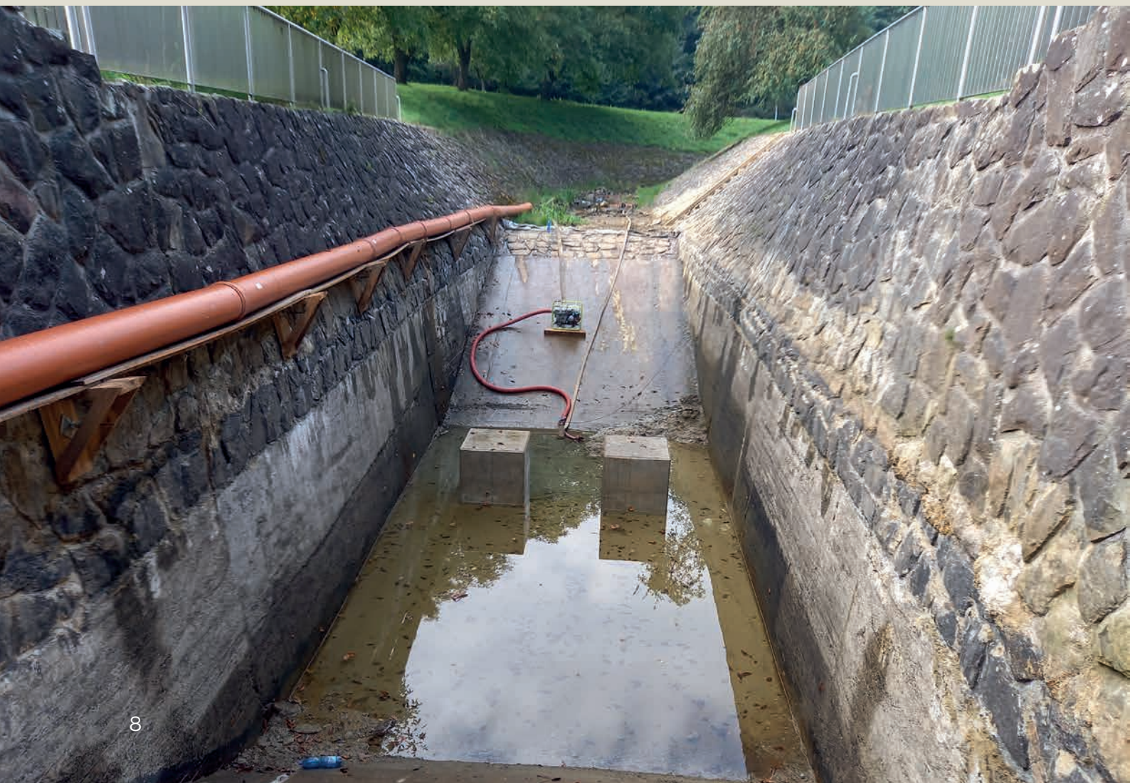
Montáž výztuže nových rozrážečů na VD Bojkovice ↑ Nové rozrážeče ve vývaru ↓
