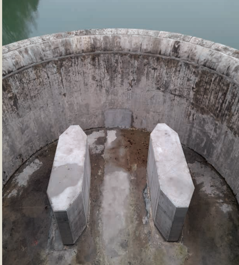
Již hotové nové rozražeče v bezpečnostním přelivu ↑
