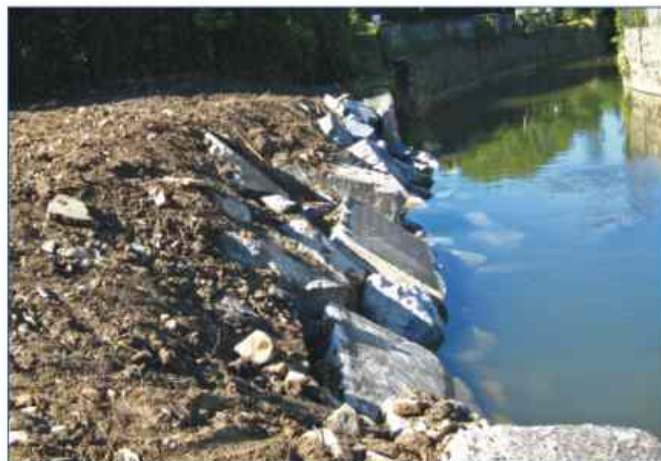
Provizorní zajištění Veličky v Hranicích
