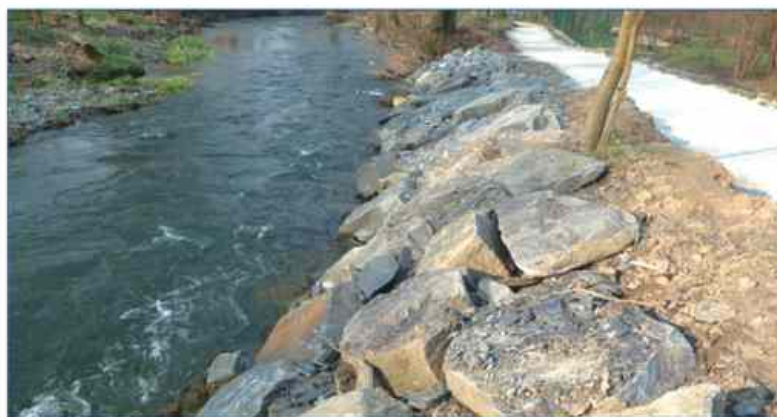
Výstavba cyklostezky podél Bystřice
