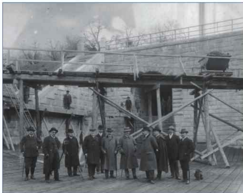
Dozorčí komise před štolou (výstavba VD Bystřička), r. 1910
