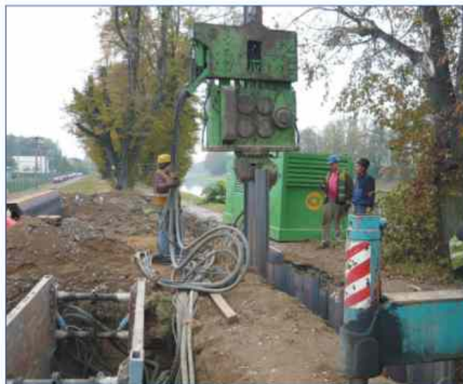
Sanace moravní LB hráze v Uherském Hradišti
