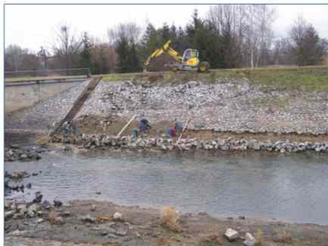
Oprava dlažeb na jezu Poštorná v Břeclavi
