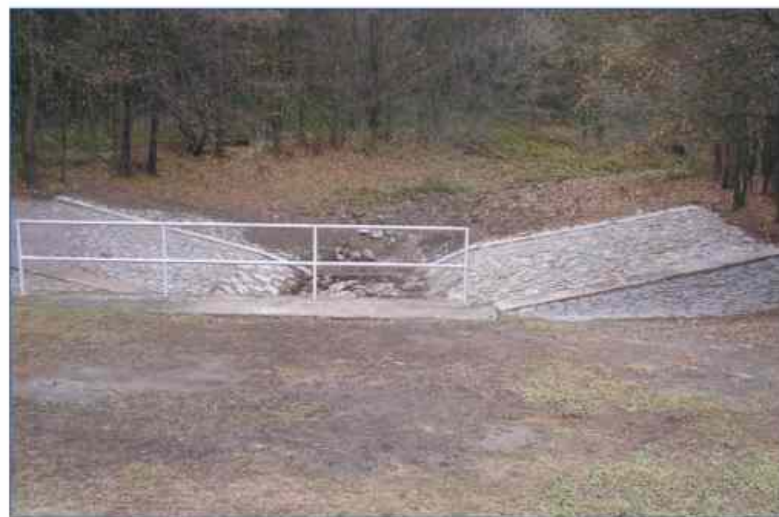
Oprava dlažeb inundačního stavidla u Moravské Nové Vsi
