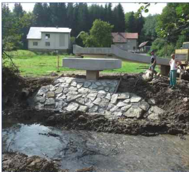
Výstavba nové lávky přes Rožnovskou Bečvu v obci Horní Bečva
