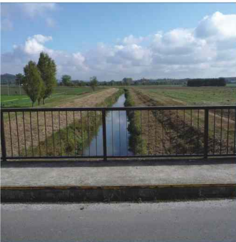
Litava – hráze v Hodějicích
