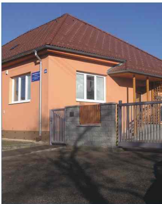
Budova provozu Náměšť nad Oslavou po opravě
