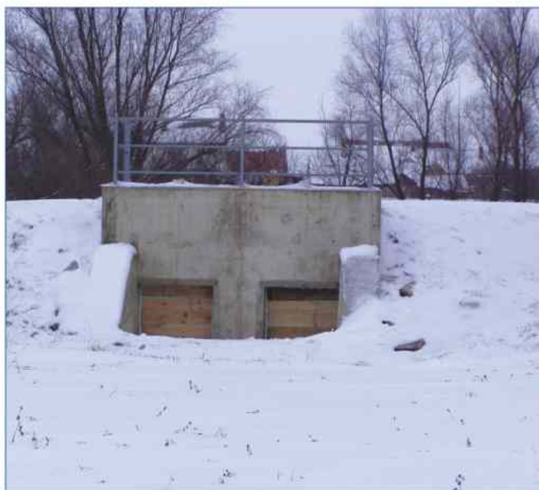
Provizorně zahrazená hrázová propust v hrázi Jevišovky
