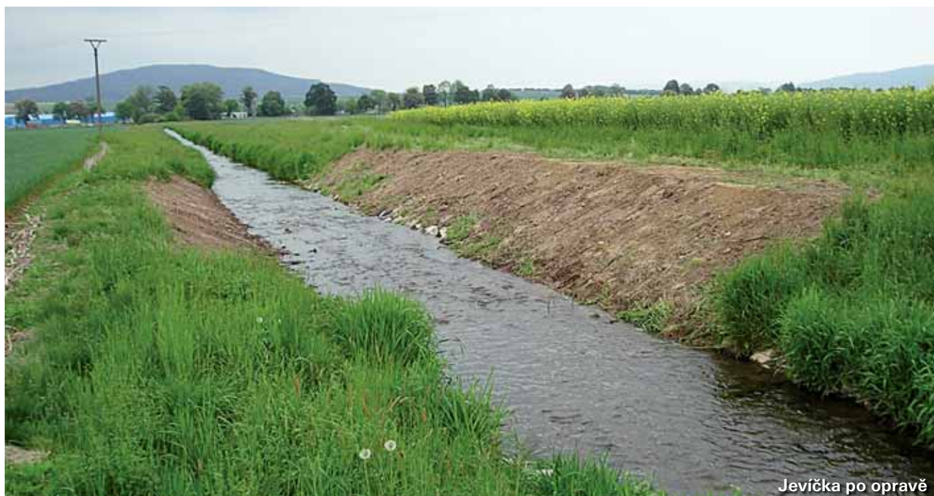
Jevíčka před opravou
