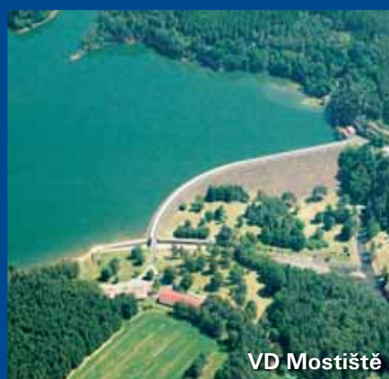
Jez s MVE na řece Jihlavě v Ivančicích
