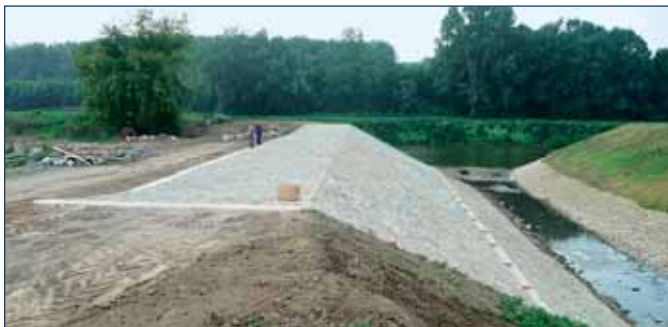
Nově vybudovaný přeliv na hrázi na soutoku Moravy se Syrovinkou
