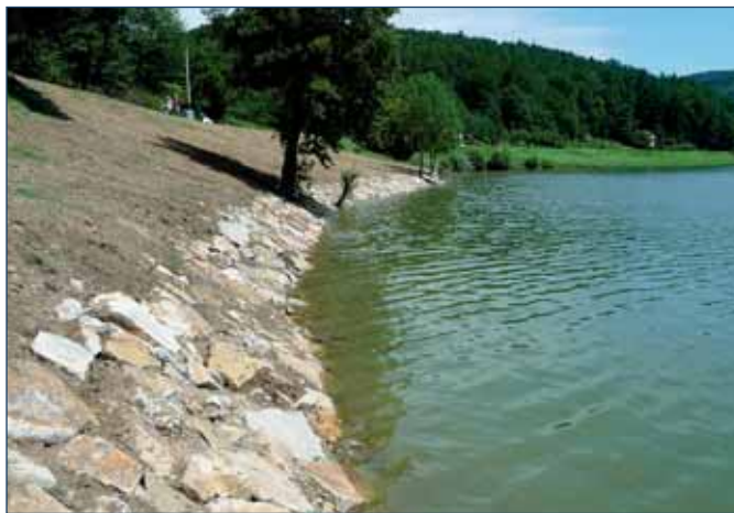
Břehové opevnění na Luhačovické nádrži
