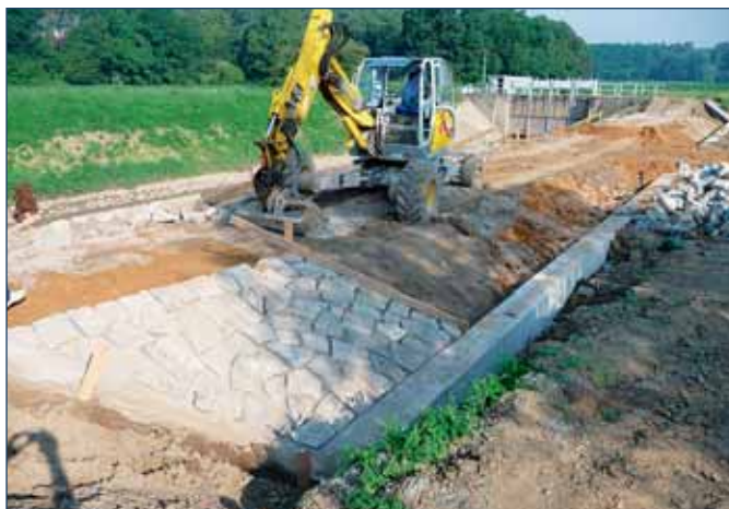
Výstavba přelivu na hrázi na soutoku Moravy se Syrovinkou
