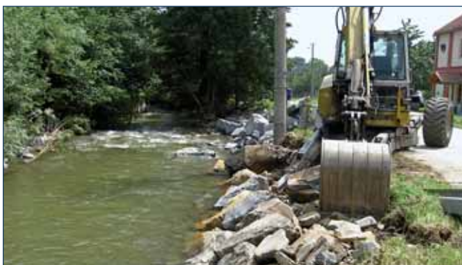
Zajištění komunikace podél Veličky ve Lhotce u Hranic
