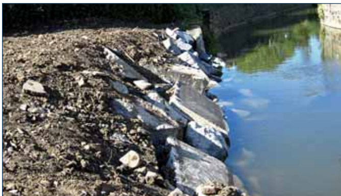
Provizorní zajištění Veličky v Hranicích
