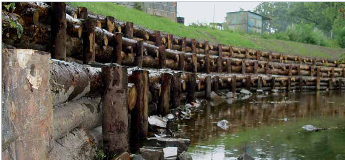
Opevnění toku Sitka v Moravské Huzové srubovou stěnou
