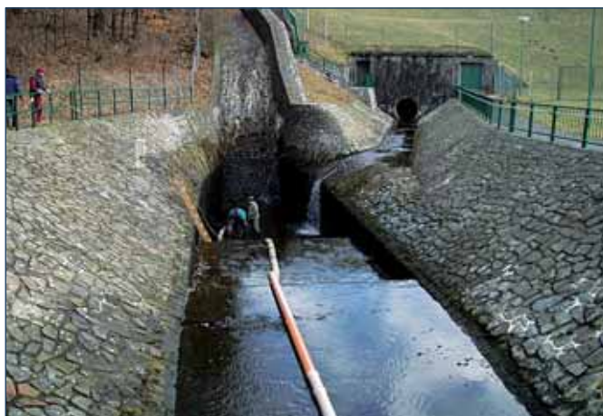
Výčerpání vývaru před jeho geodetickým zaměřením
