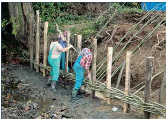
Oprava břehových nátrží vrbovým plůtkem – sestavování plůtku
