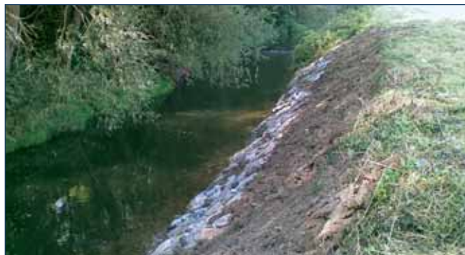
Opravená břehová nátrž na Třebůvce v k. ú. Vranová Lhota
