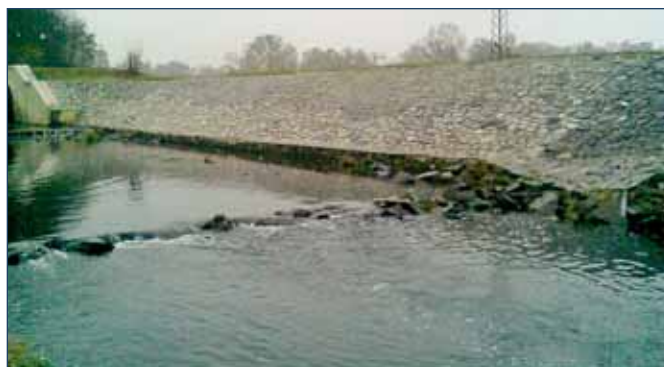
Opravené levobřežní opevnění v podjezí jezu Litovel na řece Moravě
