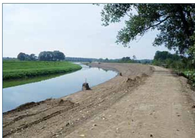
Opravený úsek PB hráze Moravy ve Vnorovech
