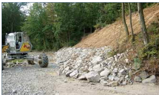
Dokončená stabilizace břehu pomocí kamenné paty
