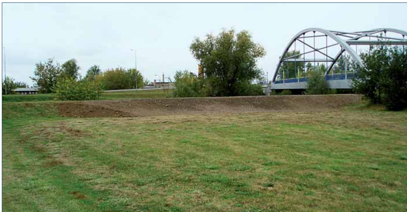
Opravený průleh levého břehu na řece Moravě v Olomouci-Lazcích
