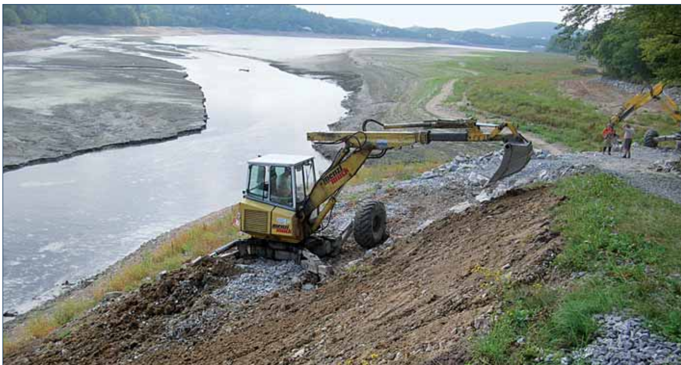
Dokončování stabilizace břehu nádrže
