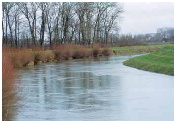
PB hráz Moravy před opravou
