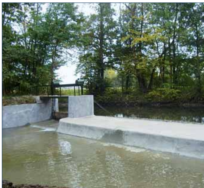
Jez Unčovice na Malé Vodě po opravě
