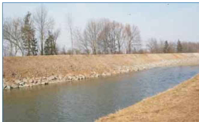
Po sanaci a před zatravněním
