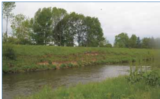
Před sanací na Svatce
