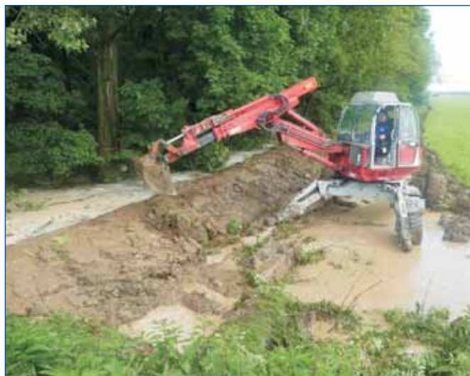
Tok Bečva, katastr Troubky - budování provizorního zemního valu, který ochránil obec Troubky před druhým zaplavením v noci z 2. na 3. června
