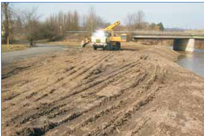
Bažinky - úprava terénu po vytěžení sedimentu
