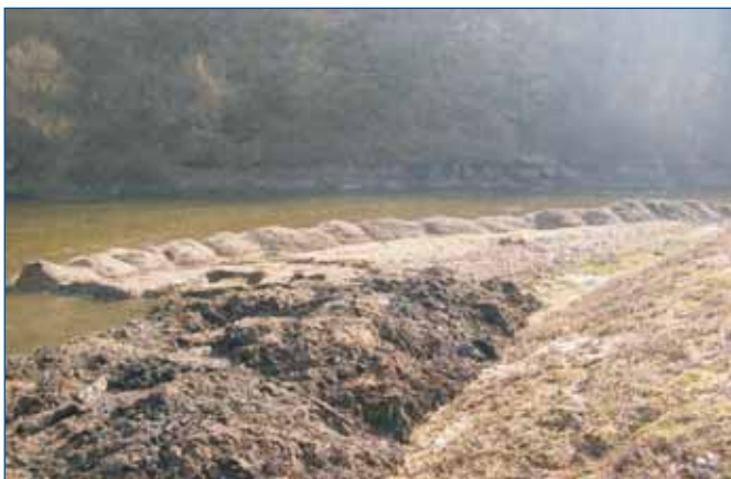
Bažinky - při provádění prací
