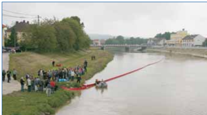
Ukázkový zásah při likvidaci ropné havárie
