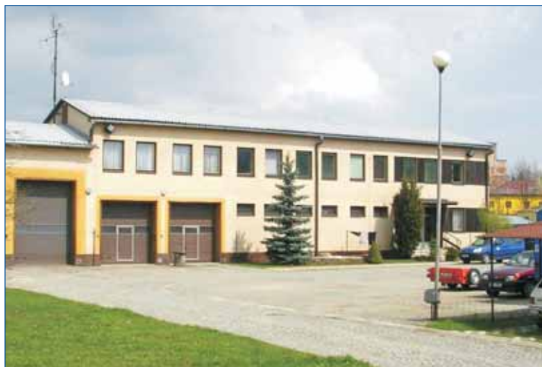
Provozní budova Jihlava
