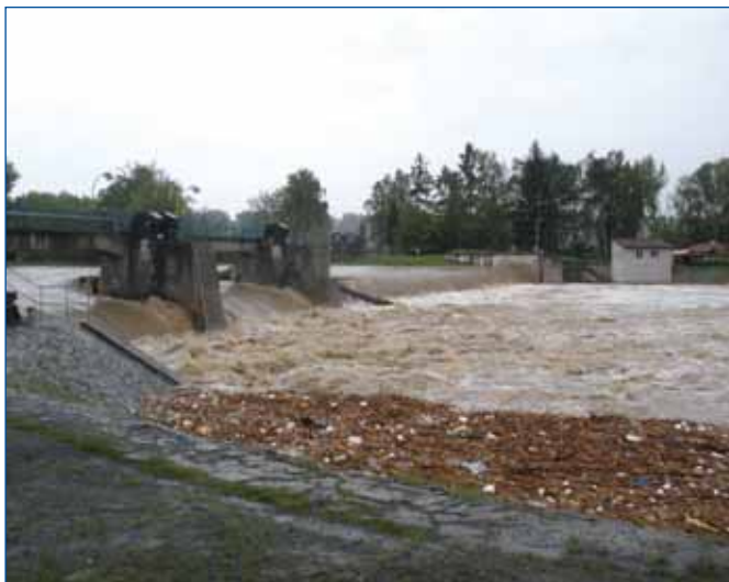
Jez Osek, tok Bečva - povodňový průtok přes plně sklopený jez
