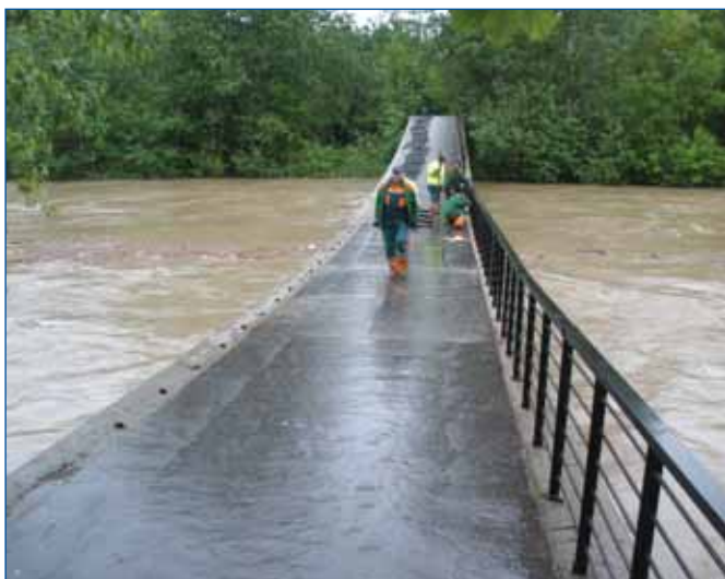
Tok Bečva, Přerov - lávka u tenisu, demontáž zábradlí na mostní konstrukci cca hodinu před jejím přelitím
