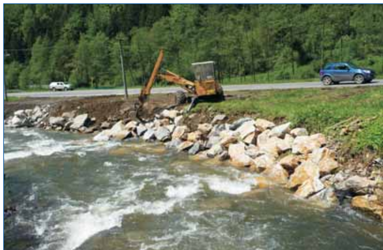
Tok Branná - oprava kamenným záhozem
