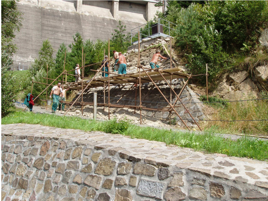
V průběhu opravy
