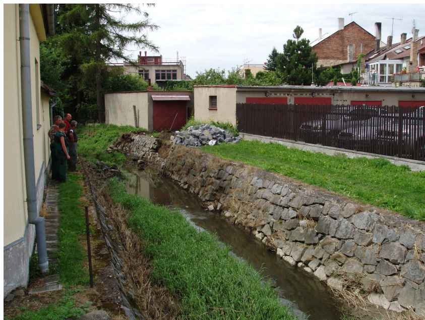
V průběhu opravy
