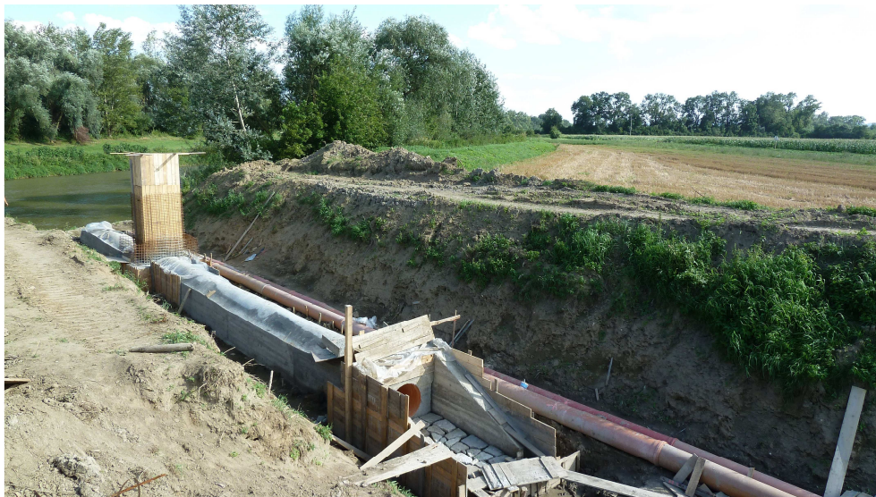
Pohled na místo stavby – zaústění Grechtu do Moravy. V místě dřevěného bednění bude umístěna šoupátková věž. Prostor mezi hrázemi bude dosypán a náležitě zhutněn.
