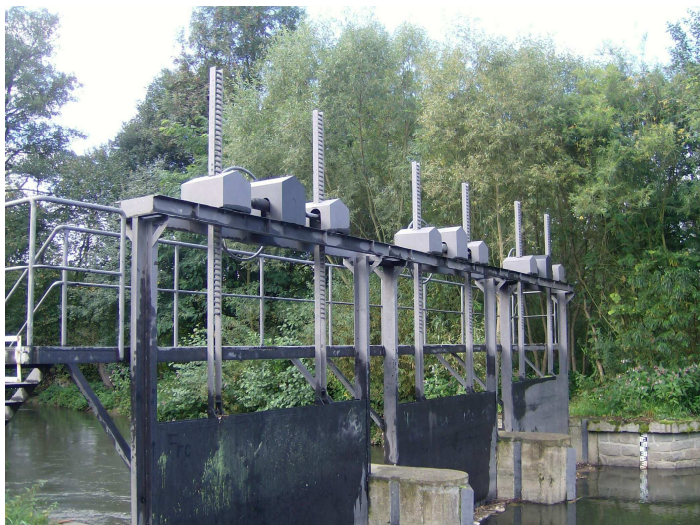
Stavidlový objekt po instalaci nových krytů
