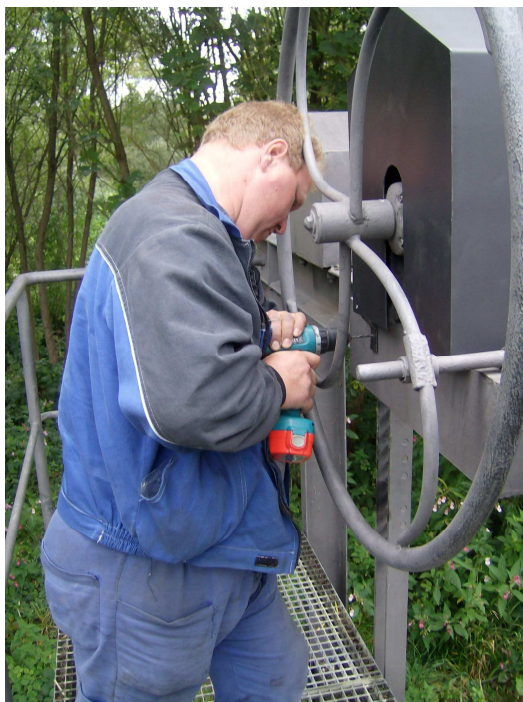
Vrtání otvorů pro uchycení krytů
