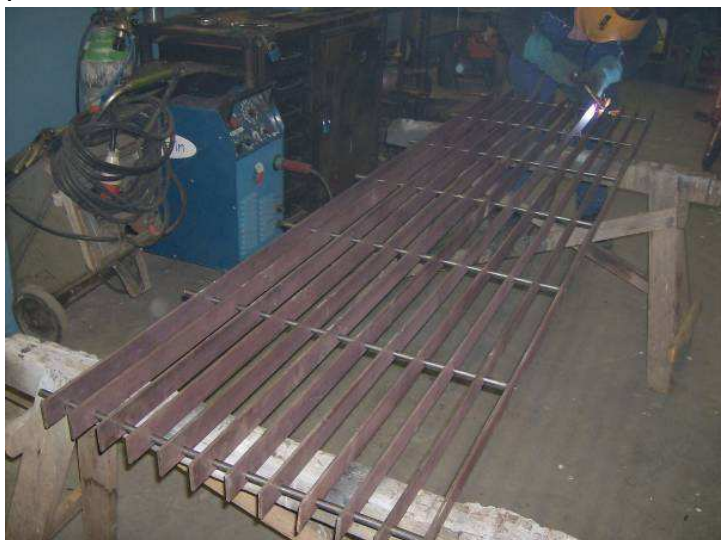
Kompletace česlí v dílně závodu. Podélné ocelové pásy byly přivařeny k jednotlivým příčným vzpěrám
