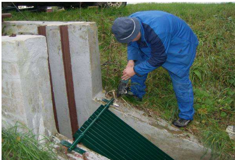
Po ukotvení česlí a po dotažení šroubových spojů se provedlo opatření proti jednoduché demontáži zařízení.
