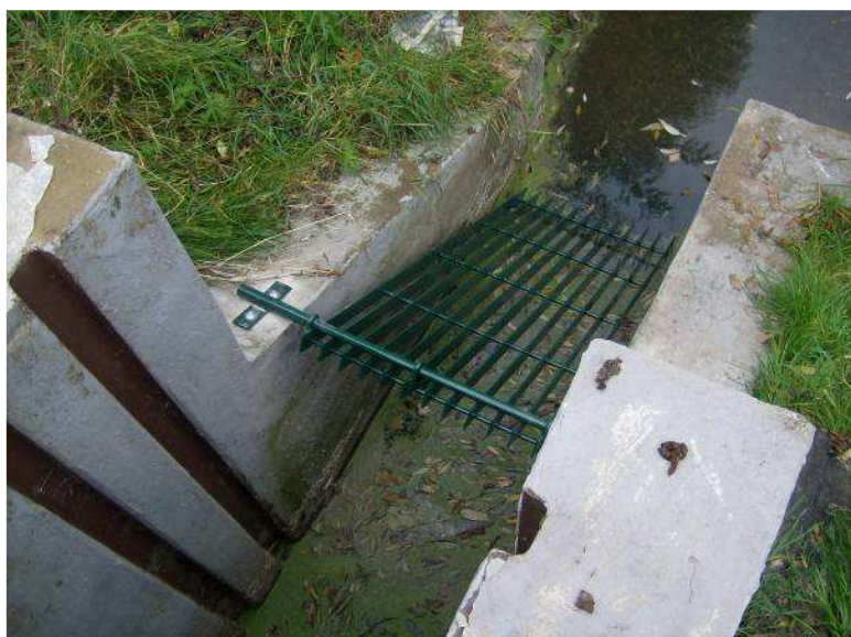
Po ukotvení česlí a po dotažení šroubových spojů se provedlo opatření proti jednoduché demontáži zařízení.
