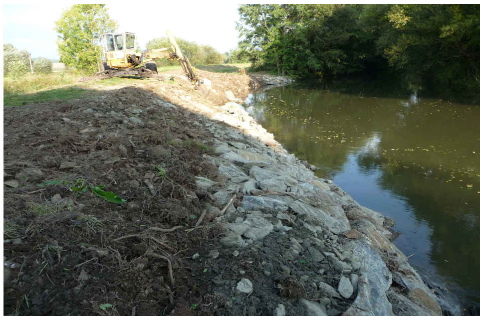
Hráz Rájec - oprava zdvojenou vrstvou lomového kamene s úpravou líce
