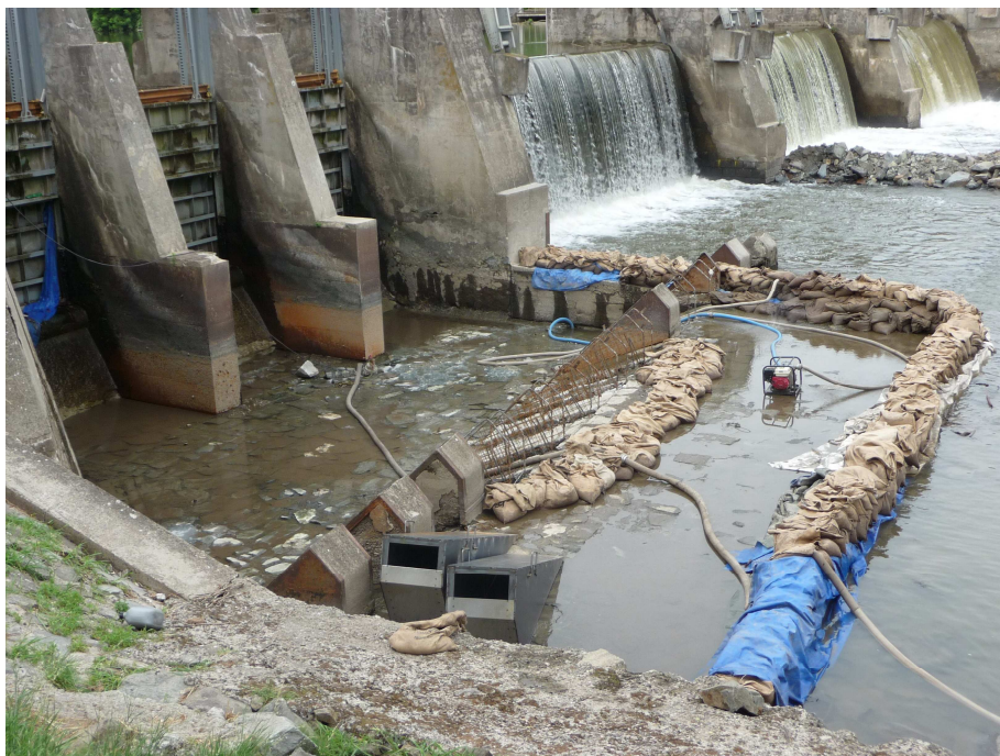
Pohled do podjezí na první jímku pod stavidly. Na horní hraně stavidel jsou navařeny ocelové náplátky utěsněné montážní pěnou, aby bylo zabráněno přepadu vody do jímky. V jímce probíhají přípravné práce na betonování rozrážečů (tvárování armatur rozrážečů, v popředí jsou připravena ocelová pouzdra).
