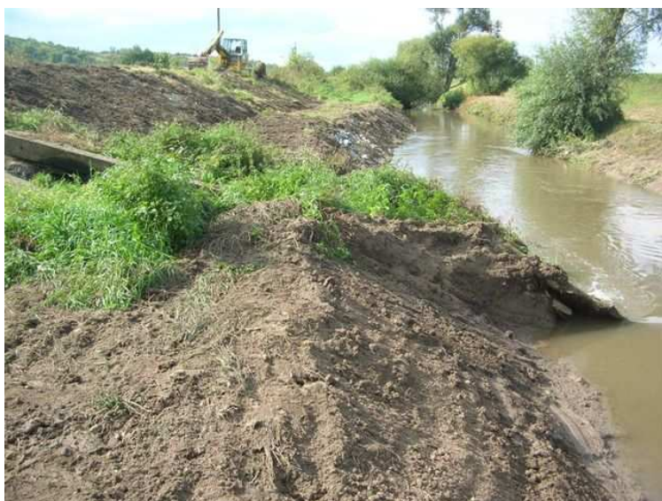
Vodní bagr při udržovacích práce
