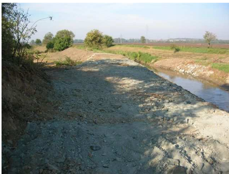
Sanované místo před dokončením povrchových úprav
