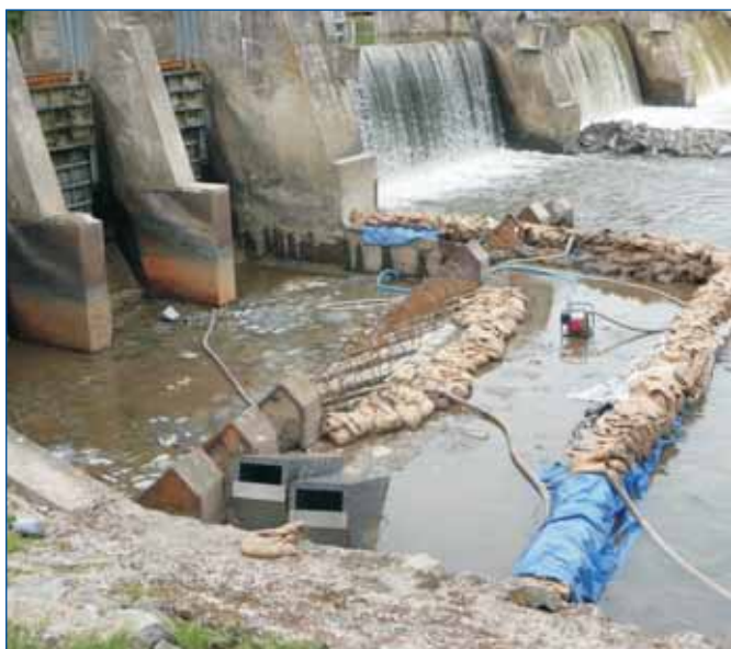
Pohled do podjezí na první jímku pod stavidly. Na horní hraně stavidel jsou navařeny ocelové náplátky utěsněné montážní pěnou, aby bylo zabráněno přepadu vody do jímky. V jímce probíhají přípravné práce na betonování rozražečů (tvarování armatur rozražečů, v popředí jsou připravena ocelová pouzdra).
