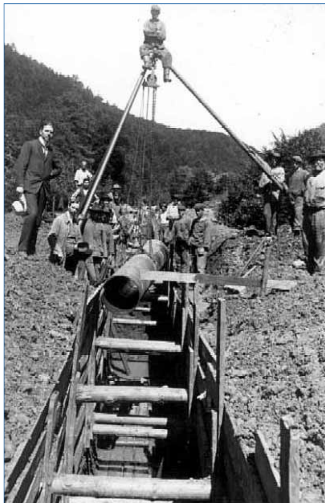
Kladení potrubí
