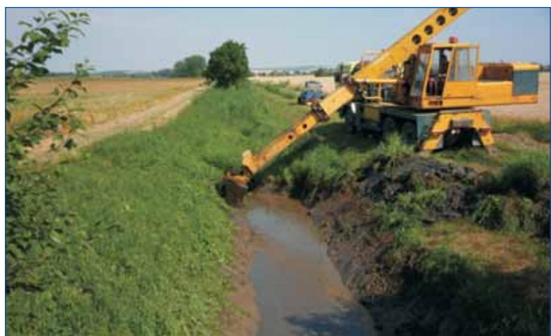
Odstranění sedimentů na toku Skalička
