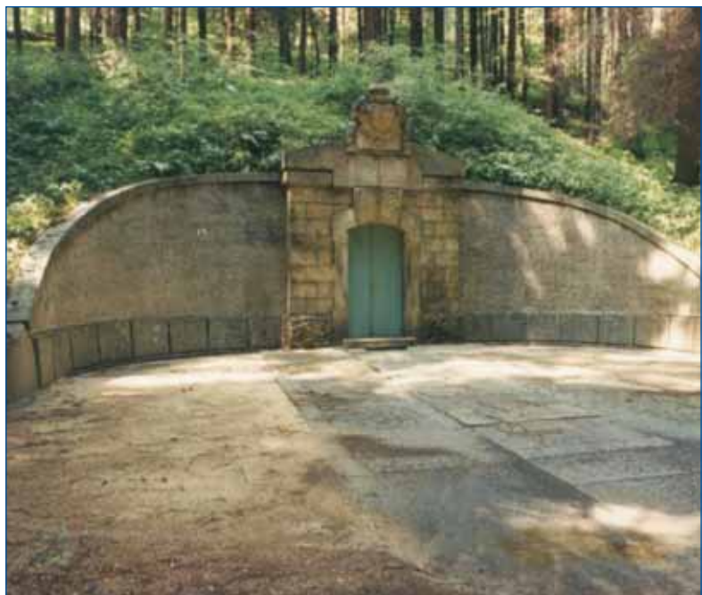
Březová - portál štoly prameniště
