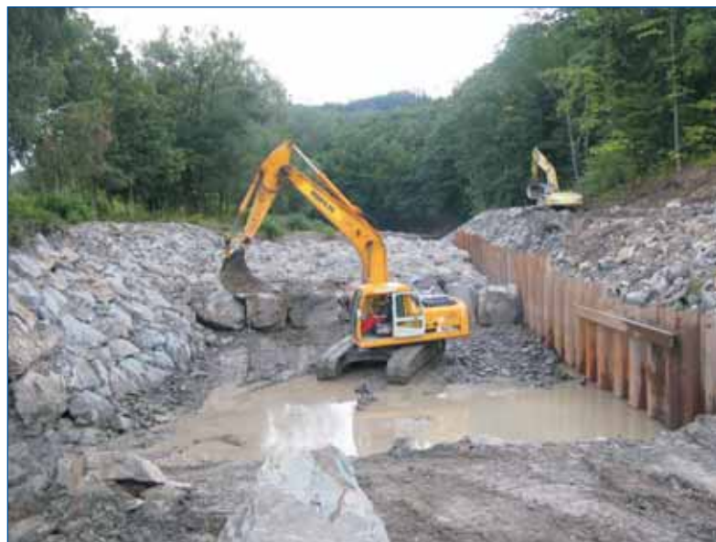
Montáž tělesa skluzu
