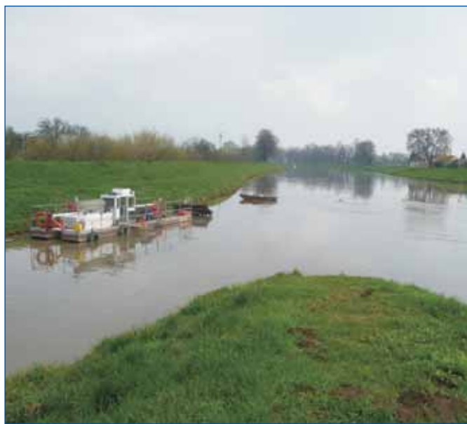
Bařův kanál - čištění rejd
