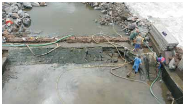
Pohled z jezové lávky do jímky pod klapkami. Čerpání a příprava sanace rozsáhlého výmolu v pravém rohu vývařiště.
