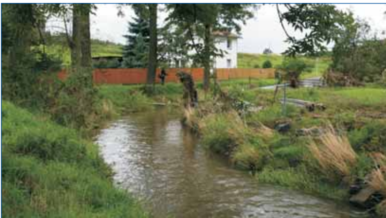
Dne 30. srpna 2010 - koryto Bystré v Markvarticích s kapacitou cca 13 \text{ m}^3 \cdot \text{s}^{-1} Povodňový průtok dosáhl v roce 2009 hodnoty cca 110 \text{ m}^3/\text{s} a v srpnu letošního roku cca 50\text{--}60 \text{ m}^3 \cdot \text{s}^{-1} . Na břehu je viditelný materiál uložený v záplavovém území.
