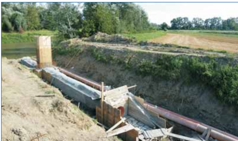
Pohled na místo stavby - zaústění Grechtu do Moravy. V místě dřevěného bednění bude umístěna soupátková věž. Prostor mezi hrázemi bude dosypán a náležitě zhutněn.
