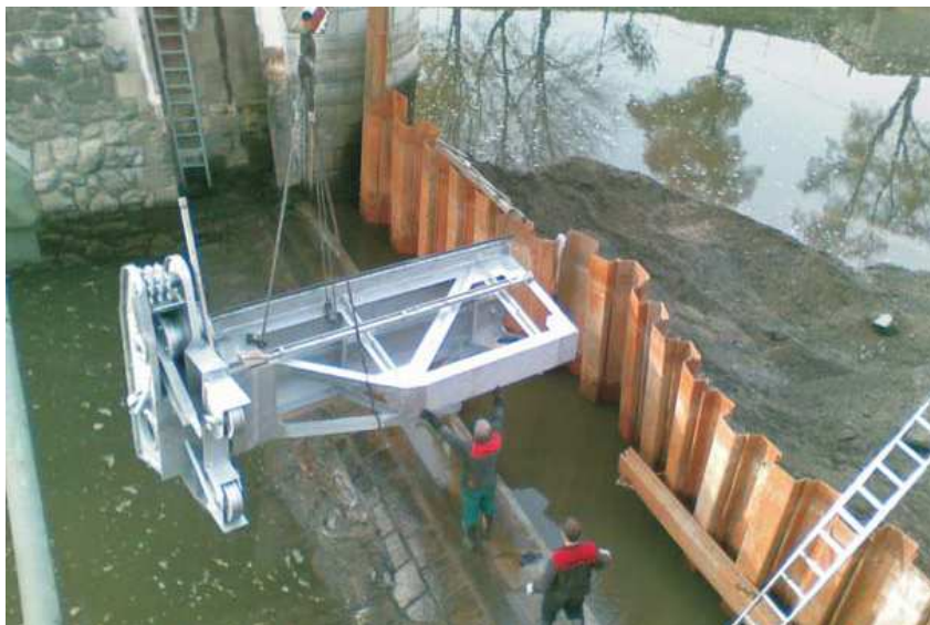
Práce na osazování jezového uzávěru
