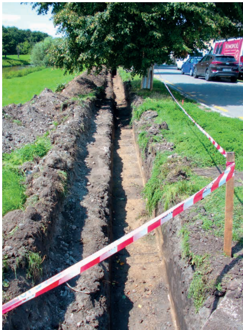
V Břeclavi začala oprava a dostavba protipovodňové zídky ↑
