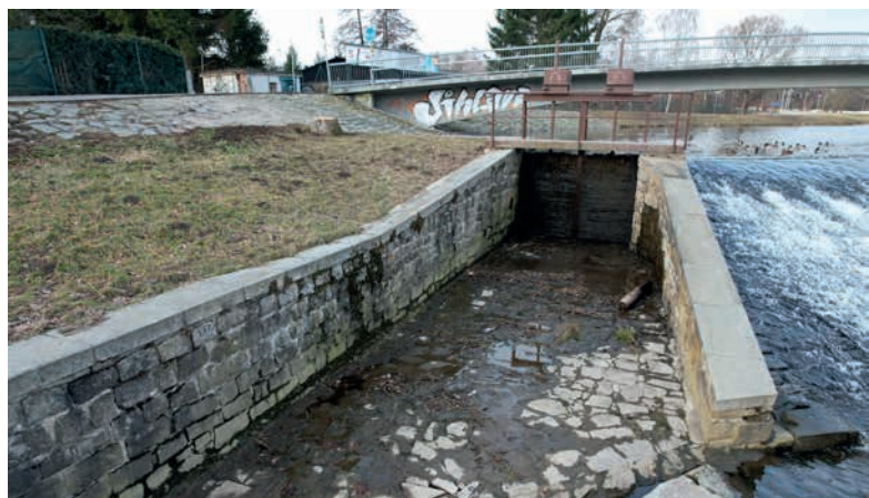
Štěrková propust' před rekonstrukcí ↑ Štěrková propust' u jezu Český mlýn v Jihlavě po dokončení její rekonstrukce ↓
