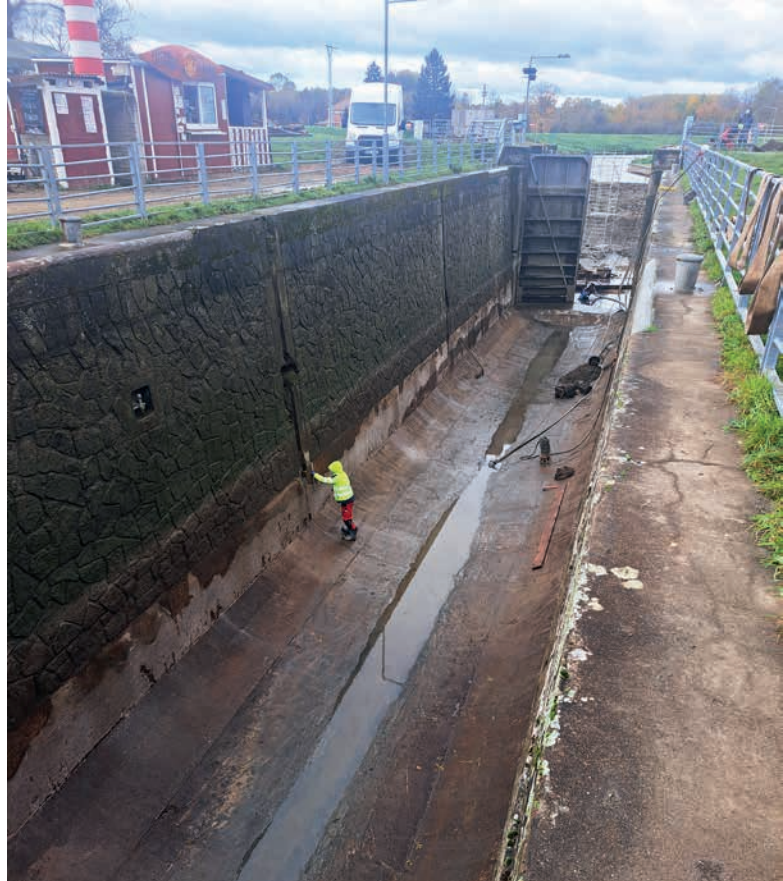
Pohled na vyčerpanou a očištěnou plavební komoru Vnorovy I ↑
