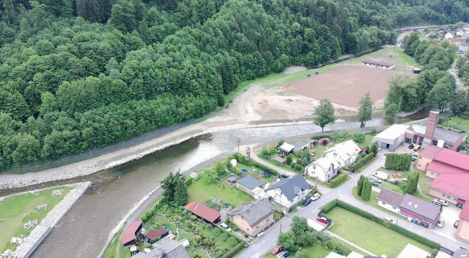
Dokončené zabezpečení lokality u hřiště v Hanušovicích ↑
